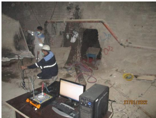
شکل ۱۸- اجرای آزمون برجای در ایستگاه در حال ساخت بهار شیراز خط ۶ مترو تهران
